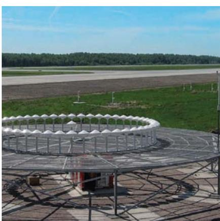
**DVOR – VHF Omnidirectional Range:** estação transmissora, com alcance de até 370 km, que permite ao piloto identificar a sua posição e também a radial sobre a qual está se deslocando.
